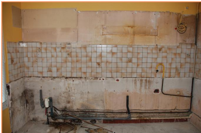
L'office de la cuisine de la cantine municipale a été complètement restructurée : dépose des ensembles paillassé, meubles en bois, plan de travail carrelé, réseaux plomberie, retrait des anciennes machines à laver, etc. et installation du nouvel aménagement : éléments tout inox (table à glissement, goutte vide déchets, douchette pré-lavage, lave-vaisselle frontal avec adoucisseur incorporé, table du chef adossée, étagère, armoire haute pour rangement vaisselle, armoire frigorifique).
